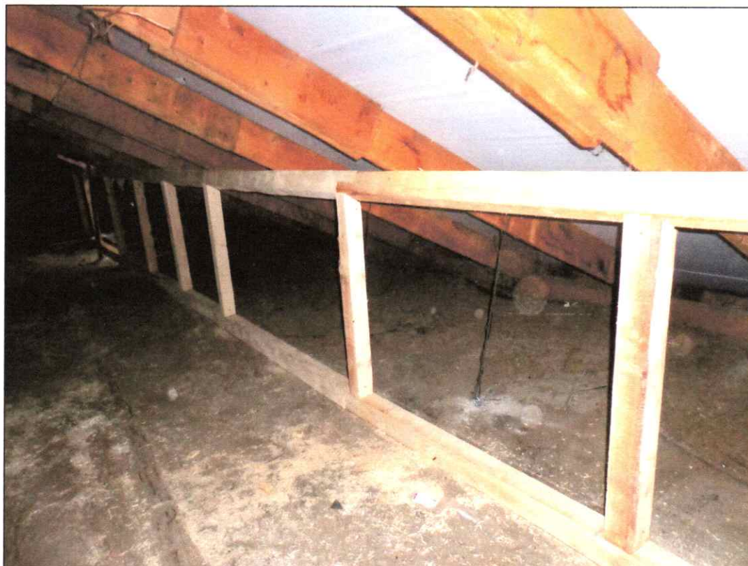
Світлина 2. Опорні рами під крокви.
