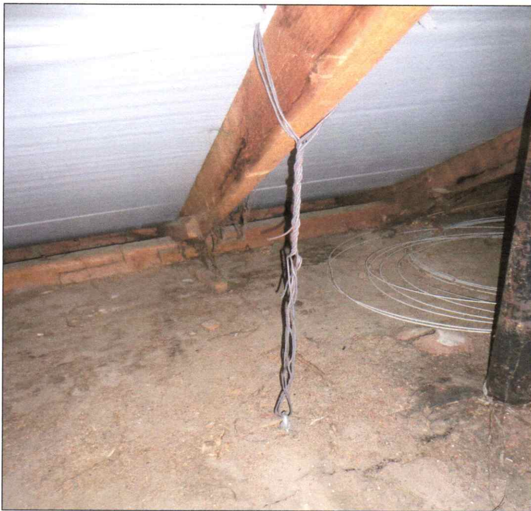
Світлина 1 Анкеровка крокв корпусу № 2 під металочерепицю.
